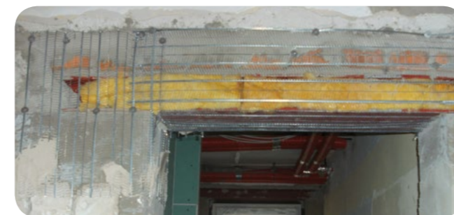
Rippenstreckmetall als Putzträger über neuem Stahlträger Durchgang Herren-Umkleide/-WC
