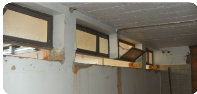
Tiefergelegte Fensterbrüstung in den Umkleideräumen
